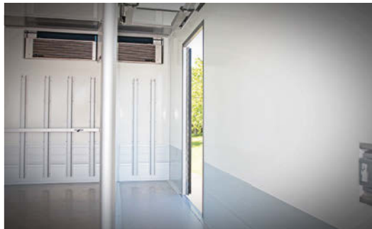
Die umlaufende Scheuerleiste schützt die Ware vor Beschädigungen.
